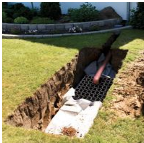
Figur 7: Klimatilpasning ved lokal afledning af regnvandet. Vindinge er Roskilde Kommunes pilotområde, hvor nedsivning af regnvandet anvendes til at aflaste kloaknettet.
