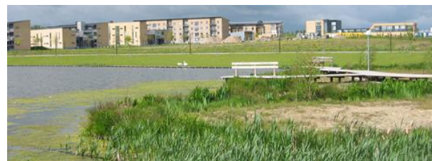
Figur 6: Ny by med indbygget klimatilpasning. I Trekroner ledes regnvandet ikke til kloakken, men afledes i render på overflade, opsamles i et større bassinområde omfattende Trekroner Søen (Bysøen og Natursøen) og et normalt tørlagt regnvandsbassin og ledes væk
