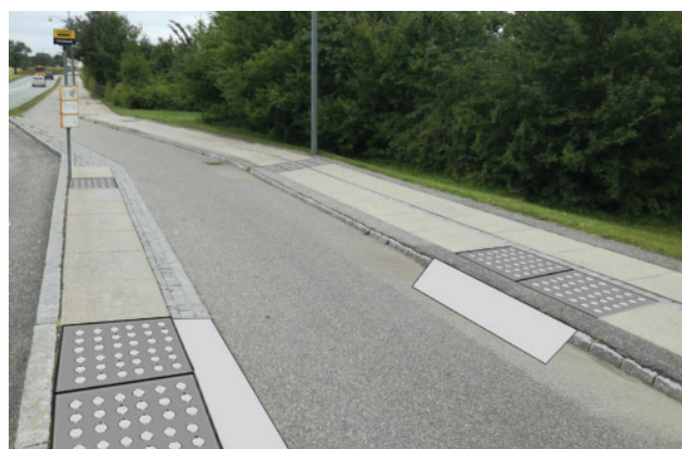
Rampe 1:10 etableres mellem cykelsti og fortov. Der etableres opmærksomhedsfelter ved for- og midterdøren. Retningsfeltet etableres ved fordøren.
