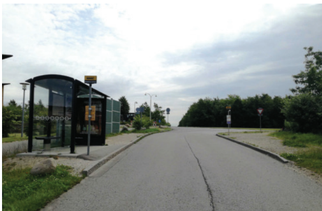
Eksempel på stoppested hvor læskærmen er for tæt på kantstenen på Herregårdsvej.
