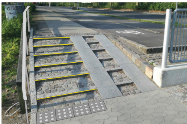
Opmærksomhedsfelter etableres til markering af trappestart, trappetrin markeres kontrastfarve og håndlister etableres i korrekt højde.
