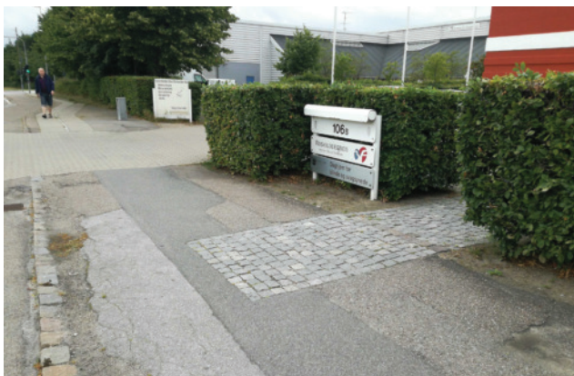
Indgangen til Dag hjem for blinde og svagsynede. Ledelinjen forsvinder pga. overkørsel og asfaltfortov, som er nedslidt
