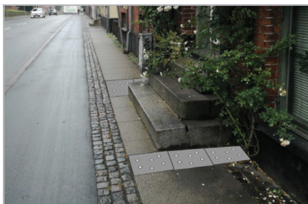
Trappeopgange der blokerer gangbanen kan være svære at løse. En lappeløsning er at etablere opmærksomhedsfelter omkring trappen for at advare om forhindringen.
