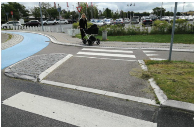
Eksempel på umarkeret krydsning og manglende lysning for synshandicappede i rundkørslen Jyllinge Parkvej/Planetvej/Kirkebjergvej.
