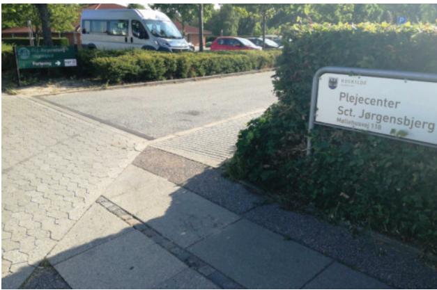
Ledelinje afbrydes ved overkørslen til parkeringspladsen ved Sct. Jørgensbjerg Plejecenter
